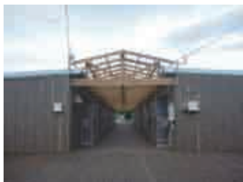
(左) ケアゾーンの仮設住宅（正面）
